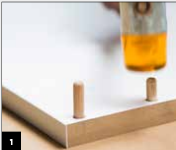
Plaats houten deuvels in de boorgaten.
