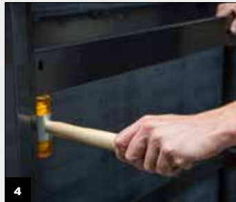
Tik de horizontale verbindingsligger iets naar boven zodat het schap geplaatst kan worden. Na plaatsing tik de ligger weer terug op de plaats.
